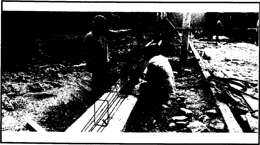
FOTO Nº05.- VHABILITADO DE ACERO EN VIGAS DE CONEXION TRAMO 4.
