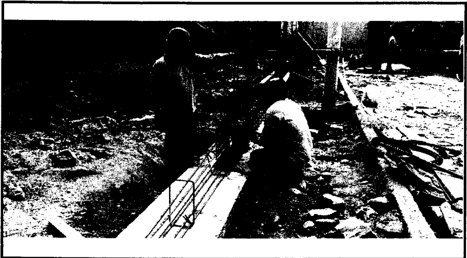
FOTO N°05.- VHABILITADO DE ACERO EN VIGAS DE CONEXION TRAMO 4.
